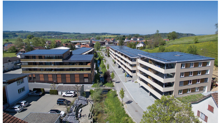
Die PlusEnergieÜberbauung in Tobel. (Bild: Stefan Wyss, FENT SOLARE ARCHITEKTUR, Wil, zentrumtobel.ch)
